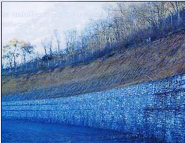
Fig. 1.54 - Consolidamento di scarpata sovrastante gabbioni metallici (Foto: Prati Armati)
