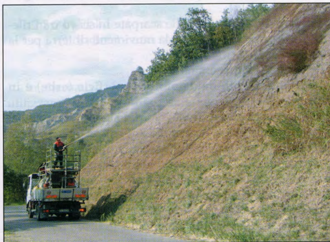
Fig. 1.6 - Inerbimento con idrosemina: fase iniziale (Foto: Prati Armati)
