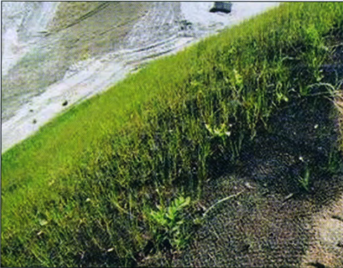
Fig. 1.13 - Rinverdimento e consolidamento di scarpate mediante l'intervento combinato di idrosemina e geostuoie. Il rinverdimen-to è al 90° giorno dall'idrosemina (Foto: Prati Armati)
