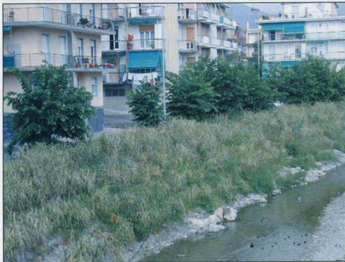
Fig. 1.41 - Protezione dell'argine di un fiume mediante piantine di Vetiver: situazione dopo 1 anno dalla messa a dimora (Foto: Prati Armati)
