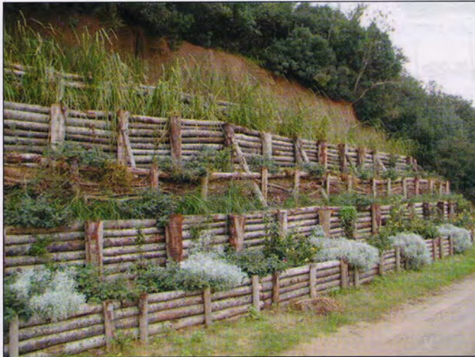
Fig. 1.60 - Opere miste per la sistemazione del piede di pendii instabili (Foto: Prati Armati)
