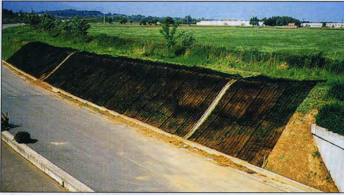
Fig. 1.12 - Georeti e geostuoie: schema di applicazione e installazione su una scarpata stradale (Foto: Rimoldi)
