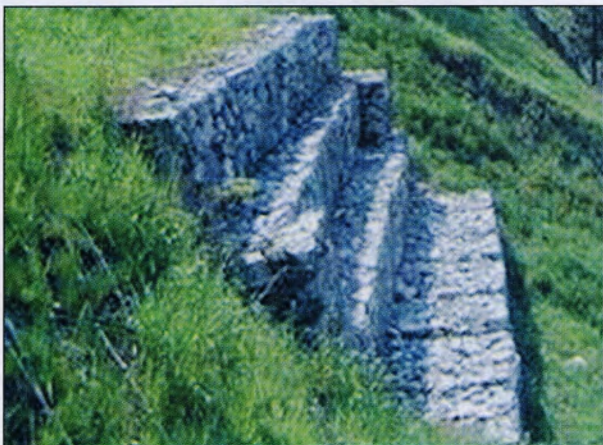
Fig. 1.55 - Rinverdimento abbinato a reti paramassi e gabbionate metalliche riempite con pietrame (Foto: Prati Armati)
