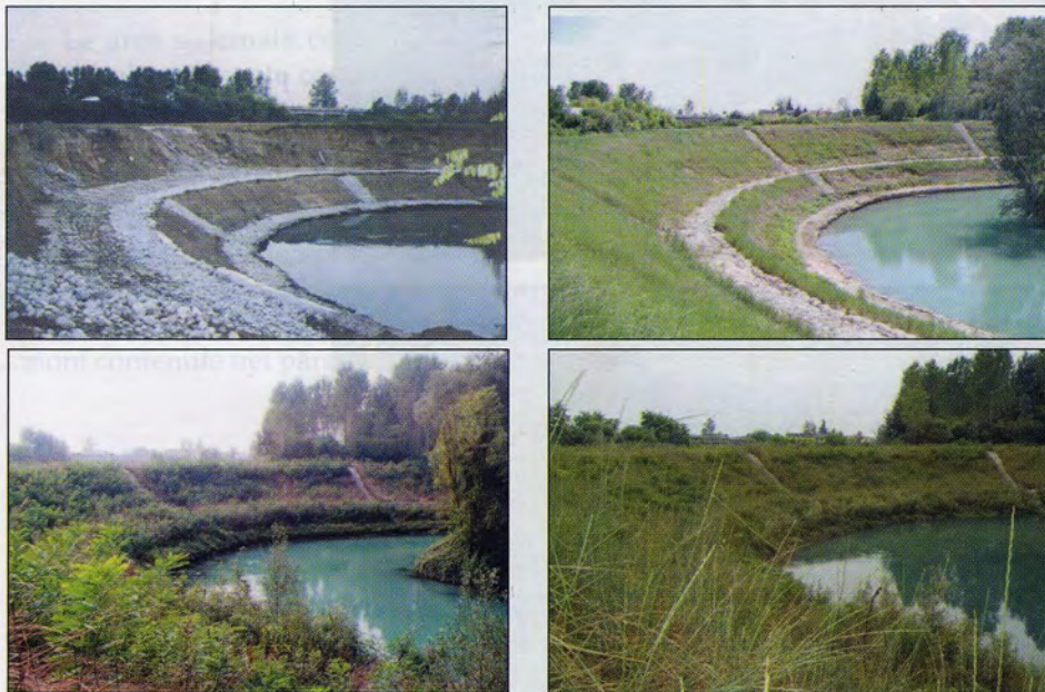
Figg. 1.34, 1.35, 1.36 e 1.37 - Consolidamento dell'ansa del fiume Noncello (PN) con tecnologia Prati Armati® e rinaturalizzazione con flora autoctona di tipo arboreo. In senso orario: impianto prima dell'intervento, dopo 7 mesi, dopo 3 anni e dopo 4 anni (Foto: Prati Armati)
